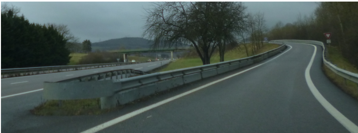
Figure 1 : illustration d'un musoir métallique (source : Cerema)
